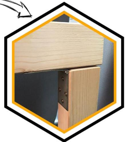
Wenn Du alle Scharniere angebracht hast ist die Unterkonstruktion fast fertig. Da das ganze Konstrukt recht wacklig ist und sich unter der Last der Auflage durchbiegen würde, nutze ich zwei gegenläufige Holzkeile um das längs verlaufende Kantholz abzustützen. Durch die beiden Holzkeile bin ich immer flexibel und kann die Höhe individuell anpassen. Du kannst aber auch einfach eine feste Auflage, je nach Abstand zur Rückbank unterlegen.
